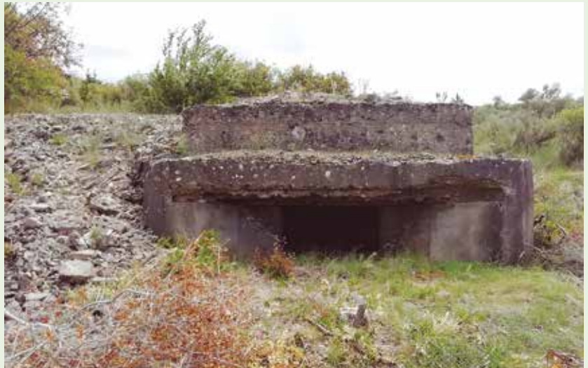
Nido de ametralladoras en el puente de Las Pilas.
