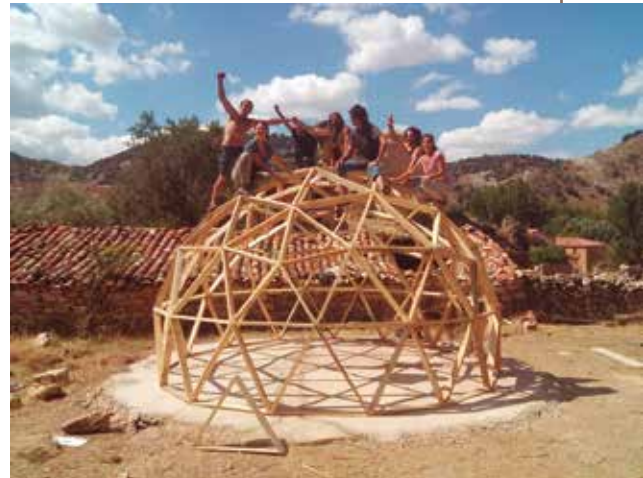
Un taller de construcción de domo.
