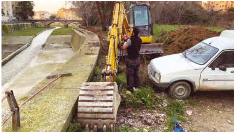
Trabajos en el Paseo de los Enamorados.
