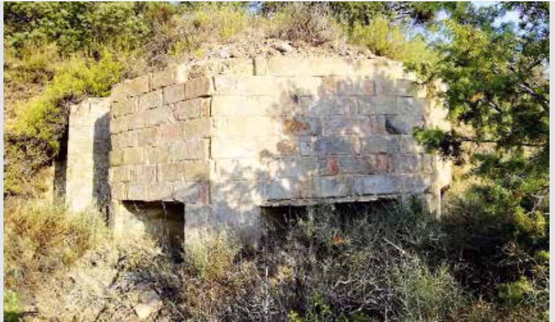
Estado actual de uno de los nidos de ametralladoras de El Grado
