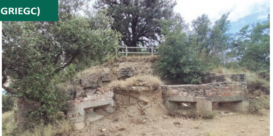
Estado actual de uno de los nidos dobles de ametralladoras de Naval.
