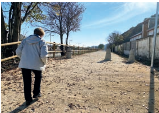
Mejoras en la rampa de acceso a la vía verde.
