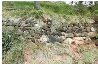
Muro de aterrazamiento en Palau, levantado con bombas volcánicas.
