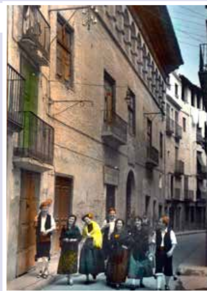
Biblioteca Pública Municipal “Argensola” en la casa Argensola, antes de su transformación. Colección del Autor.
