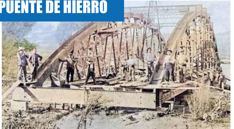
Construcción del Puente de Hierro. Archivo Jorge Mayoral
