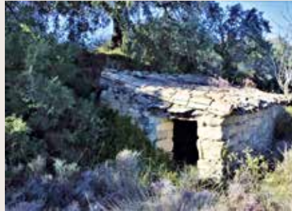
Caseta adosada a la margen
