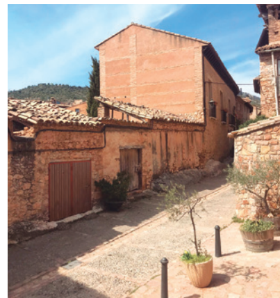
Edificio donde irá la escuela, consultorio y local social.
