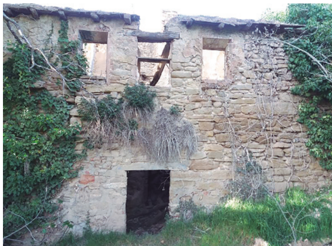
Fachada trasera de casa Lueza
