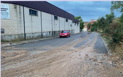
Acumulación de piedra y tierra por la última tormenta
