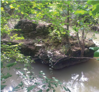
Pilares del puente de santa Fé siglo XIII
