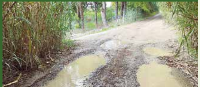
Estado del camino La Maison.
