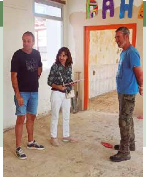
Obras en el Colegio
