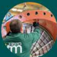
Montaje y fabricación
